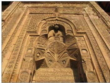
Şekil 2. Divriği Ulu Camii ve Darüşşifası Giriş Kapısı (Url-1, 2017)
