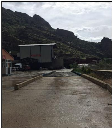
Şekil 1. Gümüşhane Katı Atık Tesisi
