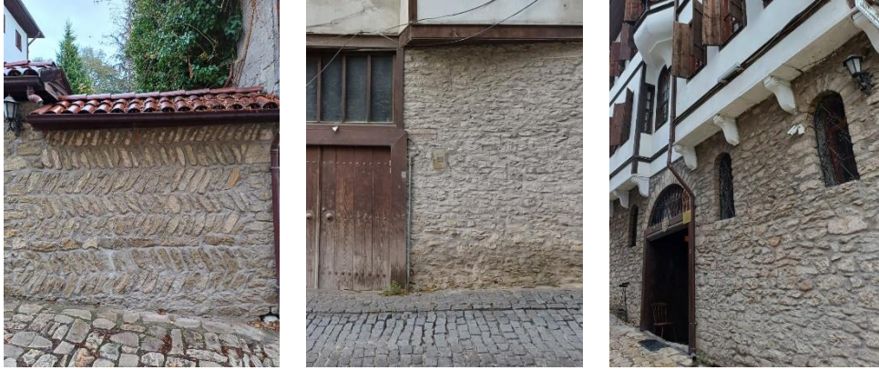
Şekil 16. Safranbolu yapılarında sokaktan izlenen taş işçilik örnekleri
