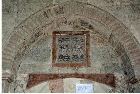
Fotoğraf 10. İnşa kitabesi
