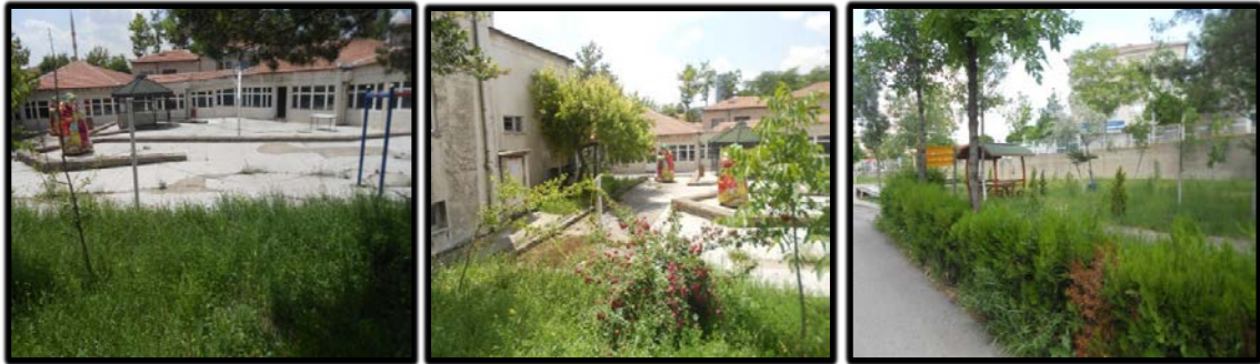
Şekil 1. Doğan Çağlar Engelliler İlköğretim Okulu arka bahçesi (bir yapıda; 13 derslik, revir, çamaşırhane)
