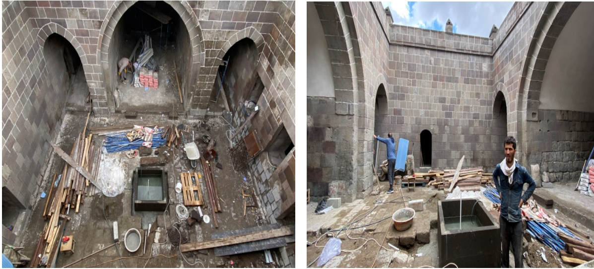
Res. 27-28: Şerefiye Medresesi Onarım Görünüşleri (Ş. Öztürk, 2021)
