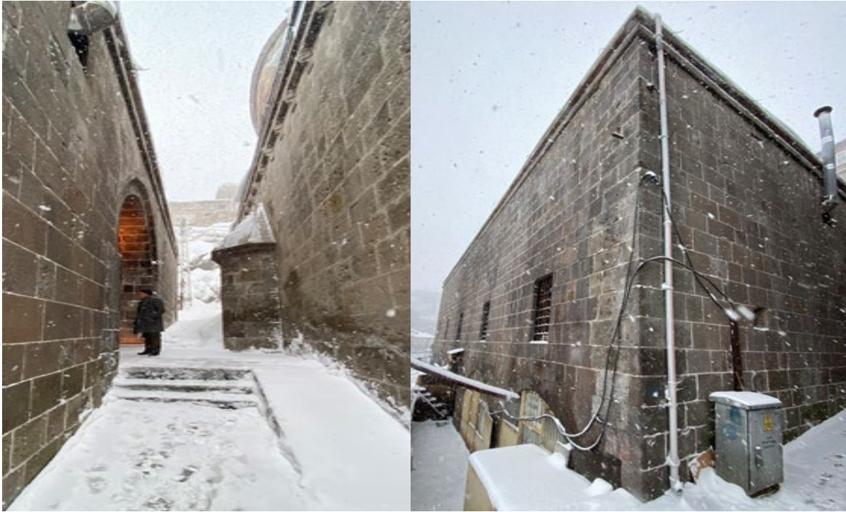
Res. 17-18: Şerefiye Medresesi Onarım Sonrası Doğü ve Kuzey Görünüřleri (Ş. Öztürk 2022)
