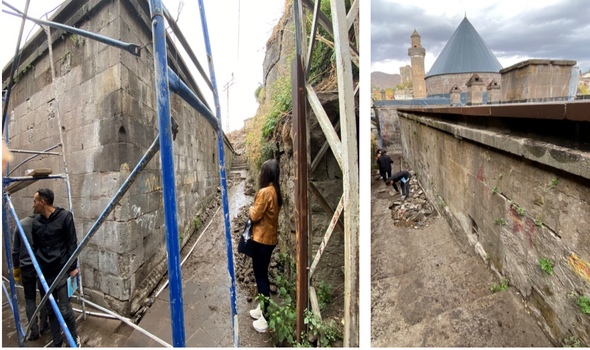
Res. 33-34: Şerefiye Medresesi Onarım Görünüşleri (Ş. Öztürk, 2021)
