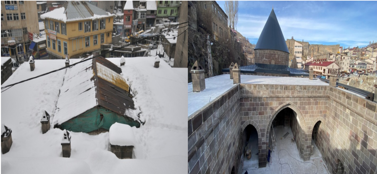
Res. 24-25: Şerefiye Medresesi Düz Dam ve İç Avlu Görünüşleri (Ş. Öztürk, 2011-22)
