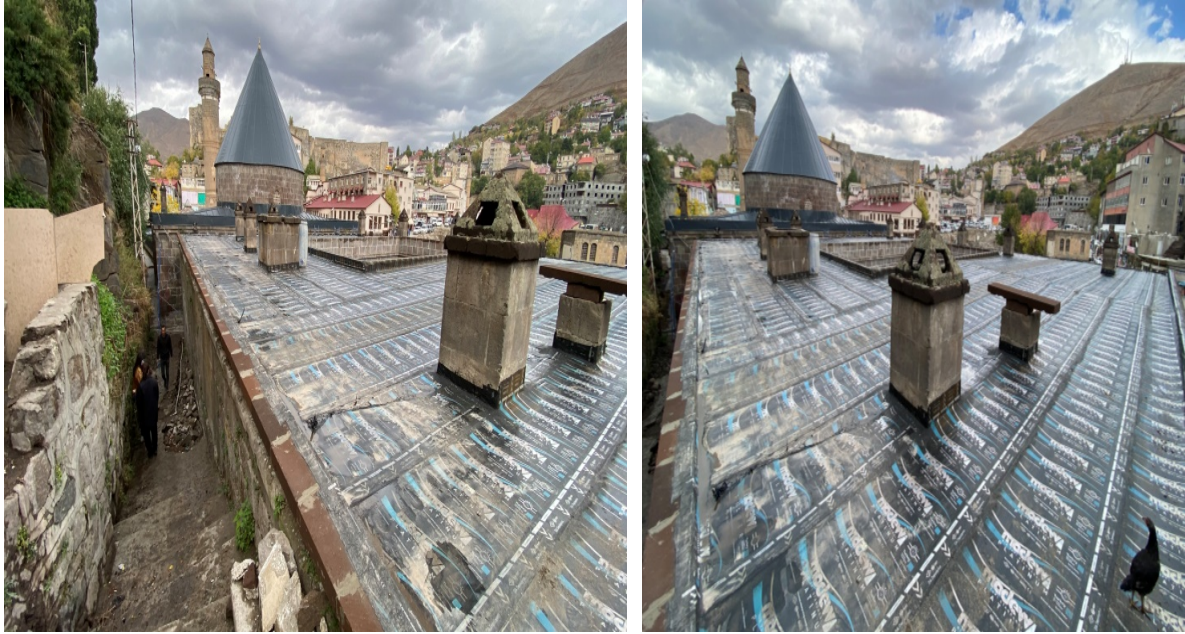
Res. 35-36: Şerefiye Medresesi Düz Dam Onarım Görünüşleri (Ş. Öztürk, 2021)
