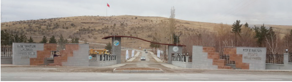
Şekil 11. Giriş Kontrol Ünitesinin Sahada Uygulanmış Hali
