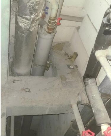
Şekil 7. İçinden Kiriş Geçen Tesisat Bacası
