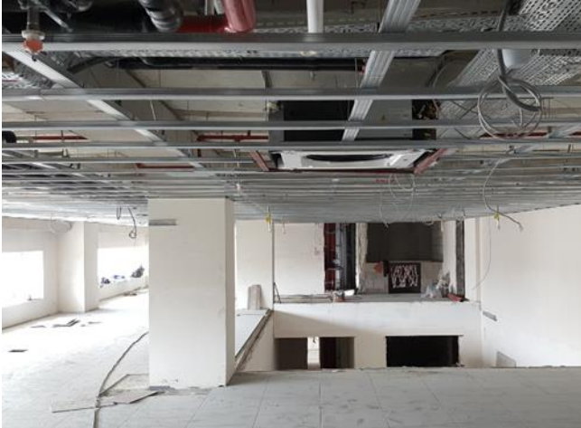
Şekil 3. Döşeme ile Asma Tavan Arasında Yer Alan Yatay Tesisat Bacası
