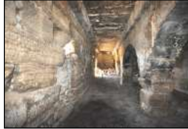
Resim 2. Ağızhan Köyü Taş Yapısı İçten Görünüm.
