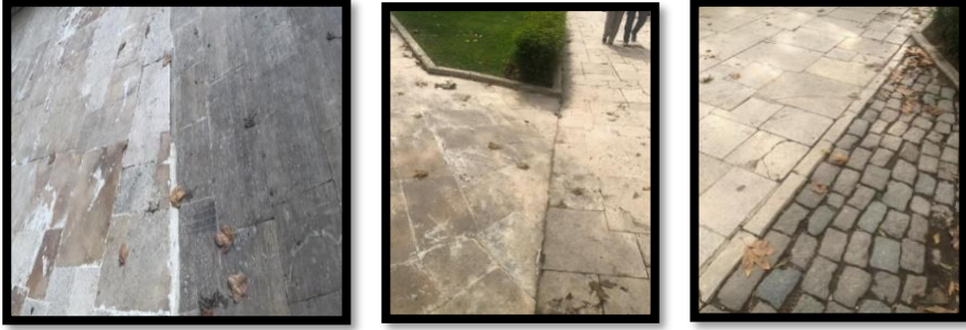
Şekil 5. Topkapı Sarayı birinci avlu, zemin kaplamaları
