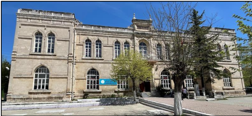
Şekil 10. Kırklareli-Pınarhisar Sadullah Koloğlu İlköğretim Okulu Ön Cephe Görünümü (Balci, 2022, s.203)
