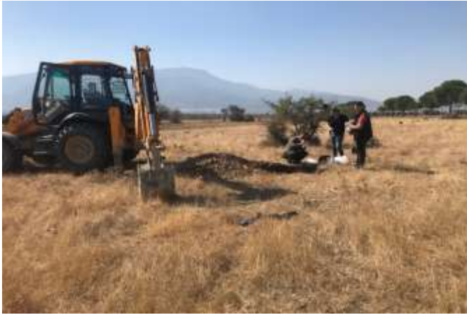
Şekil 4c. Çalışma sahasından toprak profili açılması ve toprak örneği alınması
