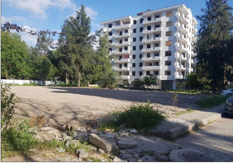
Şekil 11. Kentsel dönüşüm sürecini hasarlı yapıdan kalan boş arsa ve yıkılmayı bekleyen hasarlı yapı (Yazar Görgülü tarafından çekilmiştir, 2023)
