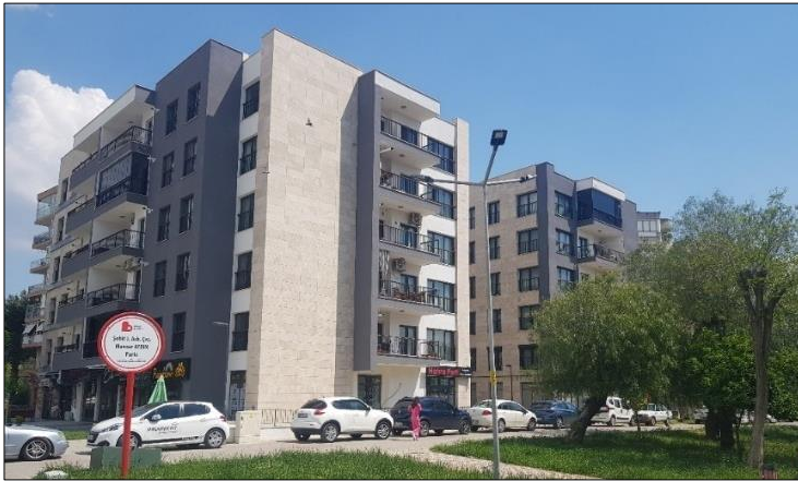
Şekil 5. Deprem sırasında yıkılan binaların yerinde dönüşüm ile inşa edilen afet konutu (Fotoğraf yazar Görgülü tarafından çekilmiştir, 2023)
