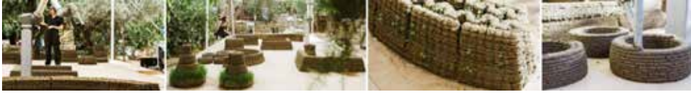
Görsel 6. Üç boyutlu yazıcı ile ekolojik mimari yapı uygulama süreci (http 13).
