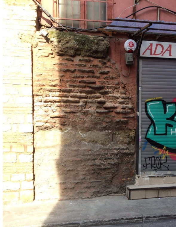
Resim 17. Arap Camii’nde Tuğla Duvar Örgüsü Arasında Tek Sıra Kesme Taş Sıraları Detayı
