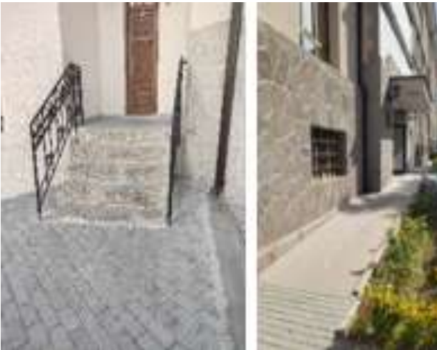
Merdiven ve Küpeşte
