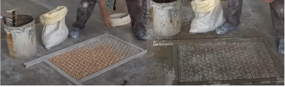
Şekil 20: Dizilen parçaların üzerinin yapıştırıcı karışım hazırlığı. 92
