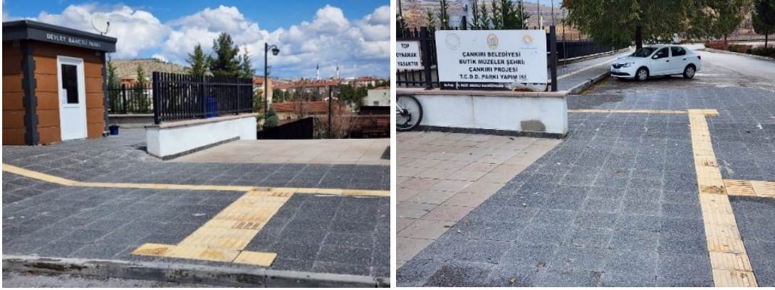
Şekil 9. Görme Engelliler için Girişte Bulunan Hissedilebilir Yüzeyler (Orijinal, 2023)
