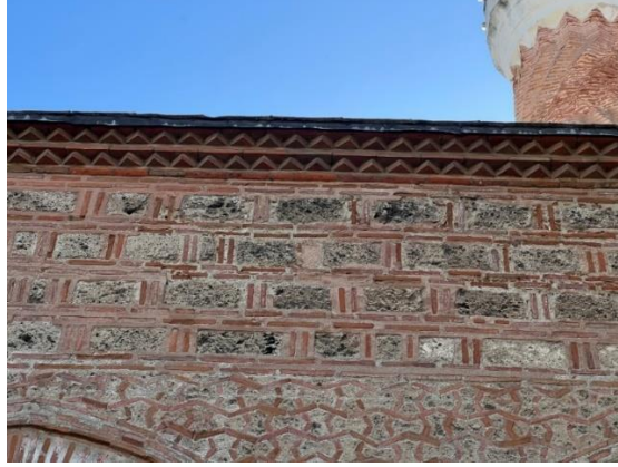
Resim 12: Şehabeddin Paşa Camii'nin son cemaat yeri duvar tekniği detayı ve kirpi saçak. Son cemaat yeri beden duvarlarında farklı dönemlere ait çeşitli sıva izleri bulunmaktadır. Beden duvarında sivri kemerli mihrabiye nişi bulunmaktadır. Üst örtü sistemini taşıyan kemerler arasında üzengi taşı hizasında ahşap gergiler görülmektedir. Zemin altıgen formu (şeshane) tuğlalardan oluşmaktadır.
