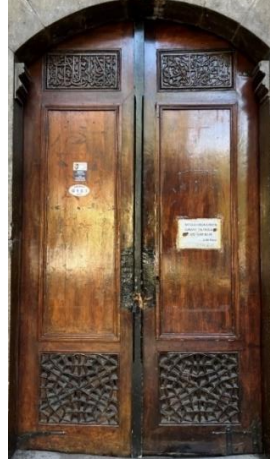
Resim 29: Cümle kapısının ahşap kanatları.
