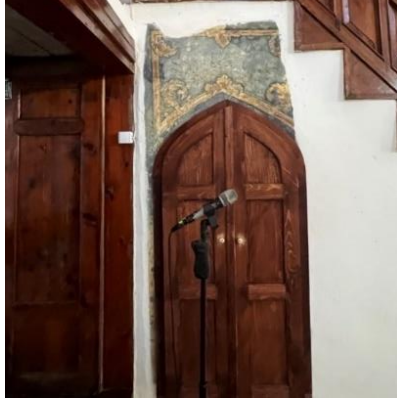
Resim 83: Minberin köşk bölümü altında kalem işi uygulamaları
