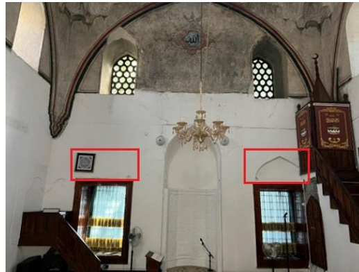
Resim 45: Caminin kible cephesi.
