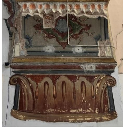
Resim 75: Sofa ile mihrap önü kubbeli birimi bağlayan kemer üzengi taşında kalem işi uygulamalarından detay.
