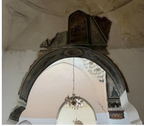
Resim 66: Batıdaki tabhanenin sofaya açılan kemerinde kalem işi uygulamaları.
