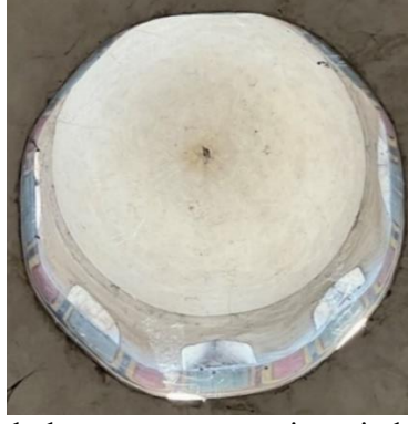
Resim 32: Sofa bölümünün üst örtü sisteminde aydınlık feneri.
