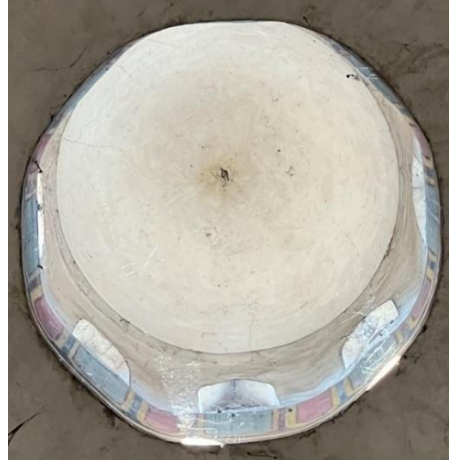
Resim 63: Sofanın üstünü örten kubbenin aydınlık feneri kasnağında kalem işi uygulamaları. Sofanın kubbeye geçiş elemanları pandantifler mukarnas dolgularla zenginleştirilmiştir. Mukarnas dolguların yüzeyinde kalem işi bezemelerin olduğu 1969 yılına ait fotoğrafta kısmen takip edilebilir.
