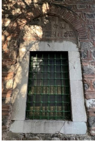
Resim 23: Güney cephedeki alt kat pencere sistemi.
