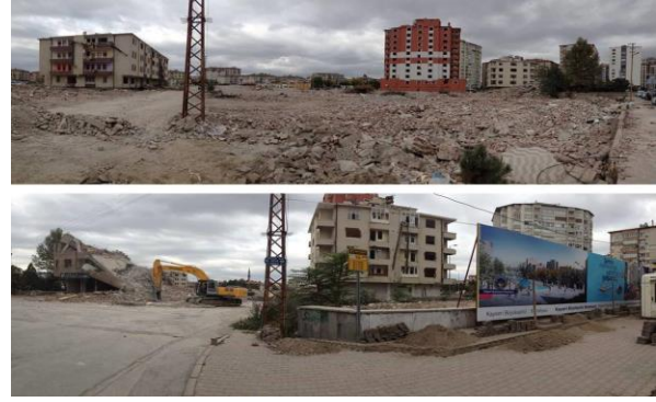
Şekil 3. Sahabiye Mahallesi'ndeki kentsel dönüşüm alanlarında yıkım çalışmaları [31]
