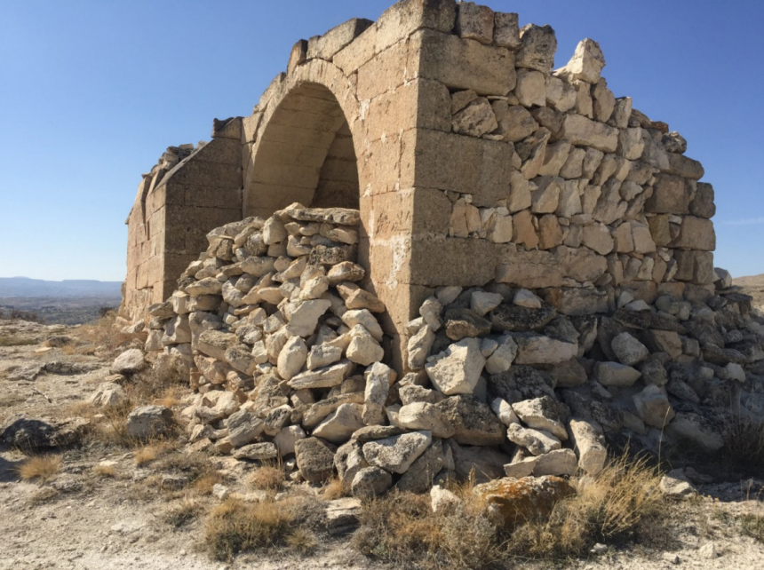
G. 11: Kuzeybatı cephe (E. Tokat, 2021)
