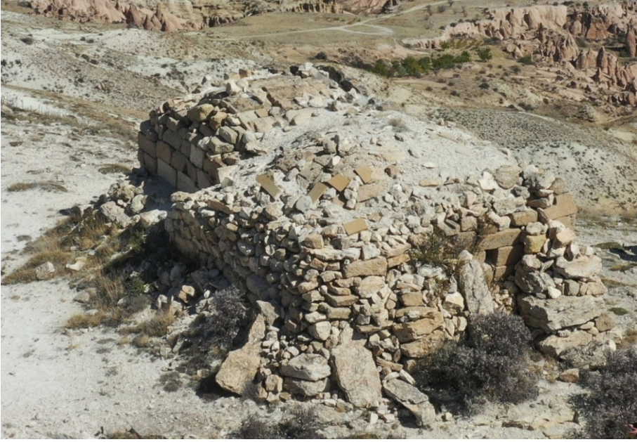
G. 10: Güneybatı cephe (E. Tokat, 2021)
