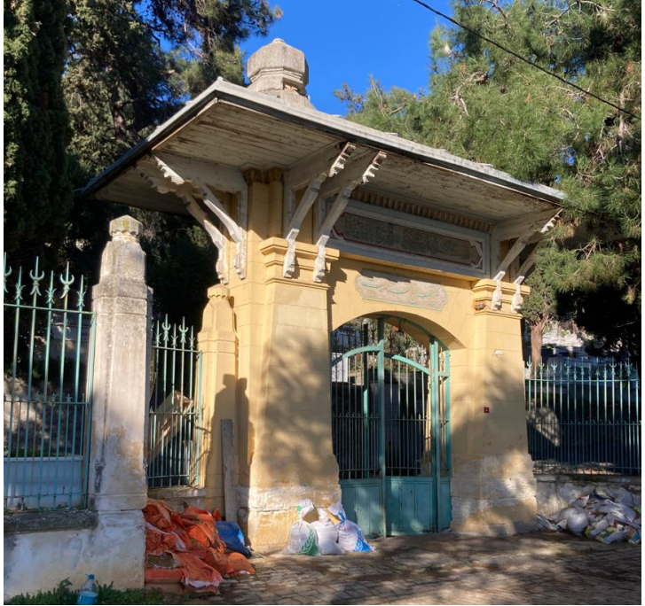
Şek. 6: Heybeliada Müslüman Mezarlığı Kapısı. (Müjde Dila Gümüş, 2024)
