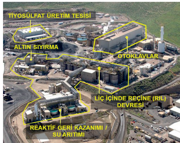
Şekil 7. Barrick Gold Şirketine ait Goldstrike tiyosülfat liçi tesisi (Nevada, ABD) (Barrick Gold, 2016; Choi, 2016)
