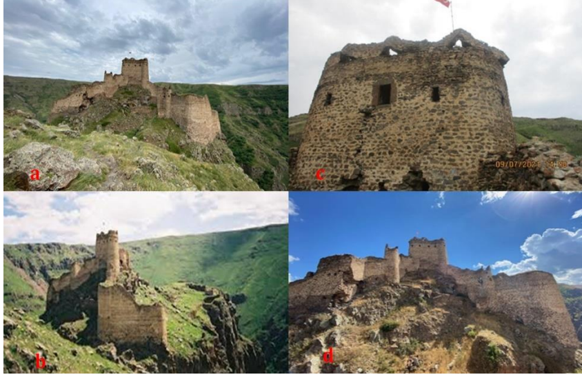
Foto. 3. a. Kalenin burç ve beden duvarları. b. Kalenin doğu bölümündeki beden ve sur duvarları. c. Ana burç üzerindeki mazgallar. d. Kalenin batı bölümündeki beden ve sur duvarları.
