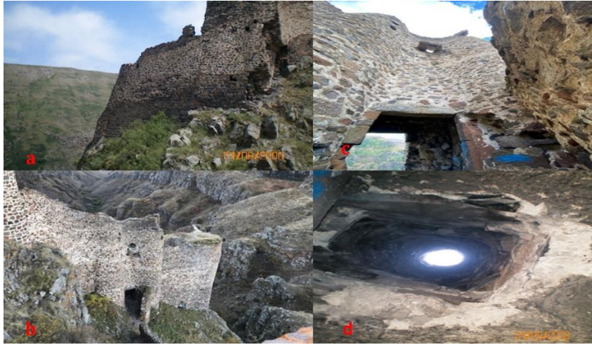
Foto. 4. a. Kalenin onarım gören beden ve sur duvarları. b. Kalenin giriş kapısı. c. Giriş kapısındaki senkendaz. d. Giriş kapısı üstündeki açıklık.
