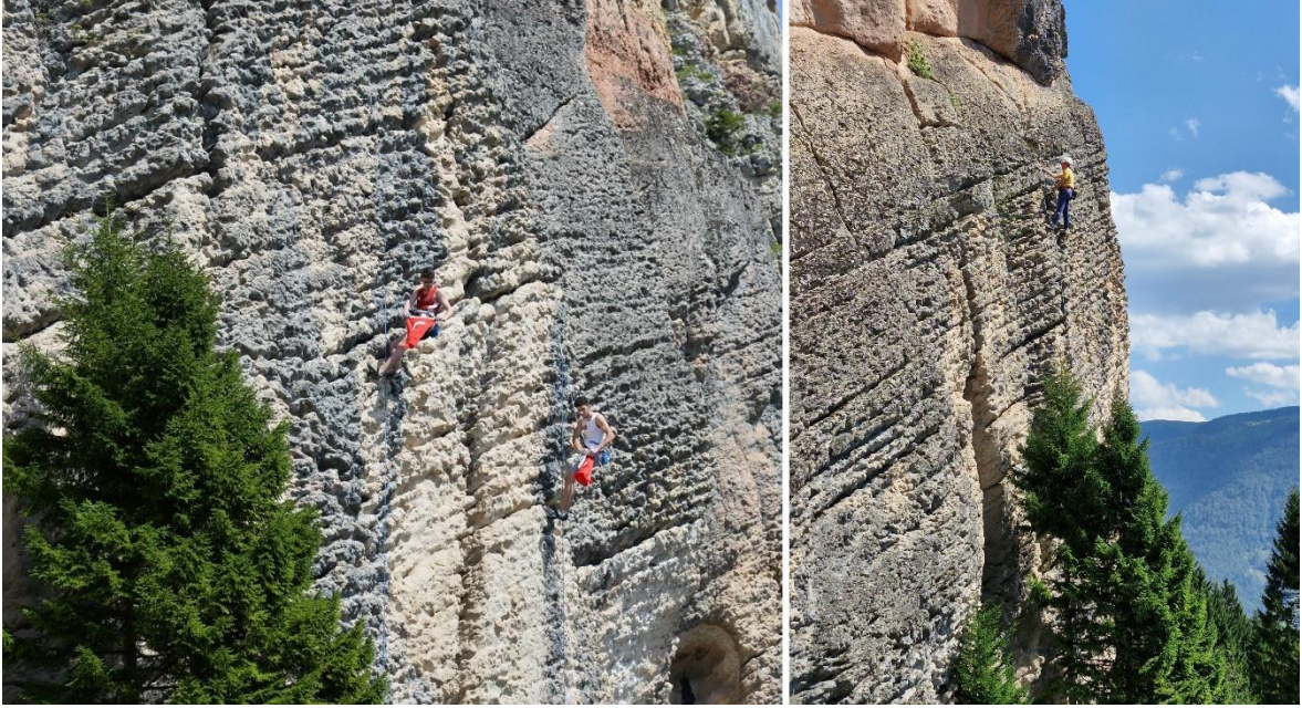
Foto-3 Doğankaya-Şahinkaya kireçtaşı tırmanma duvarının katmanlı yapıları
