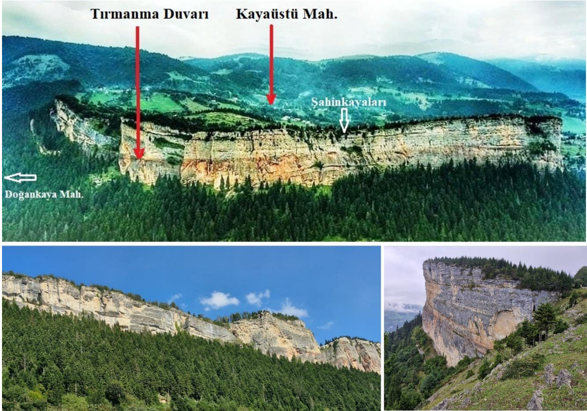
Foto-1 Şahinkaya Kireçtaşı ve dik yarlardan oluşan tırmanma duvarları
