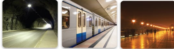
Görsel 5.15. Tünel, Metro ve Sokak Aydınlatması
