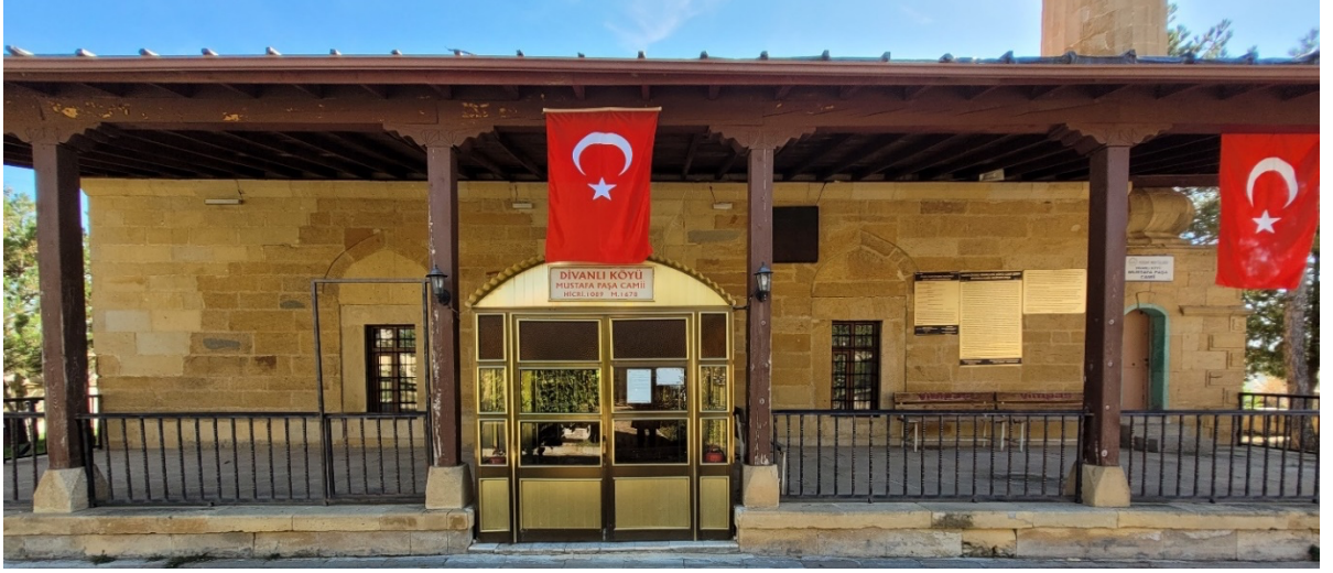
Fig. 21. Yapının kuzey cephesi ve son cemaat yeri, 2024
