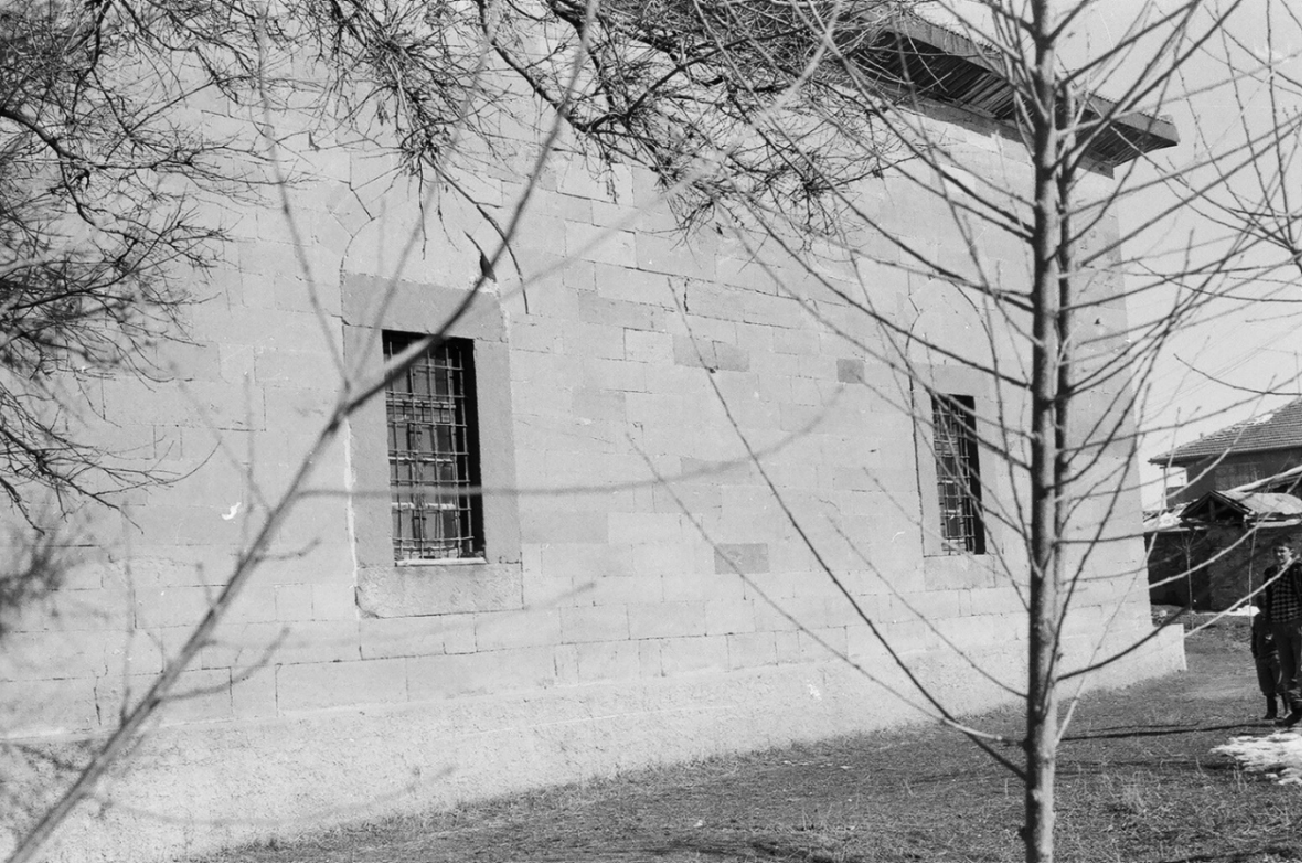
Fig. 4. Divanlı Köyü Camii'nin güney cephesinin 1990 tarihli fotoğrafı 28
