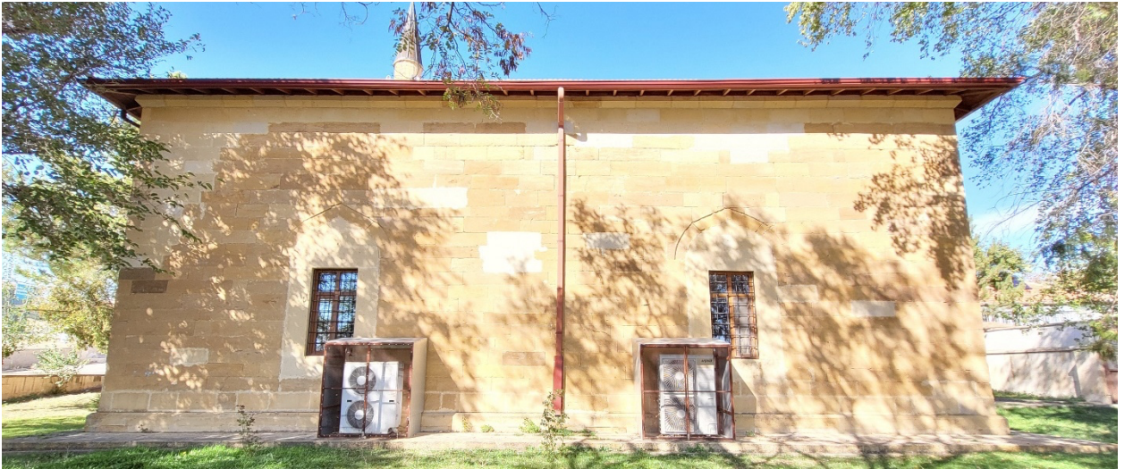
Fig. 23. Yapının güney cephesi, 2024
