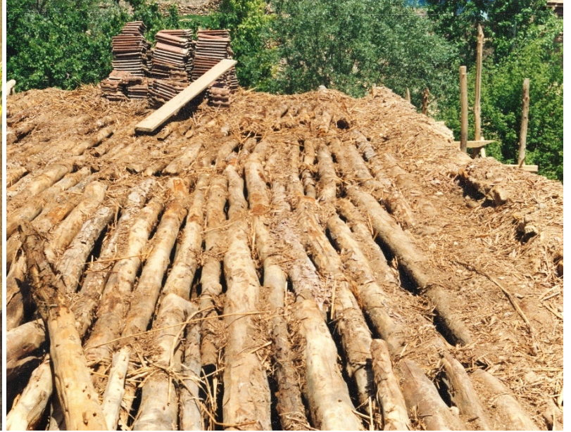
Fig. 11. Restorasyon sürecinde ahşap çatı 35
