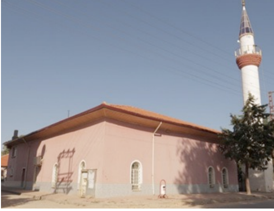
Fig. 43. Basmakçı Recep Bey Camii'nin cephesi 47
