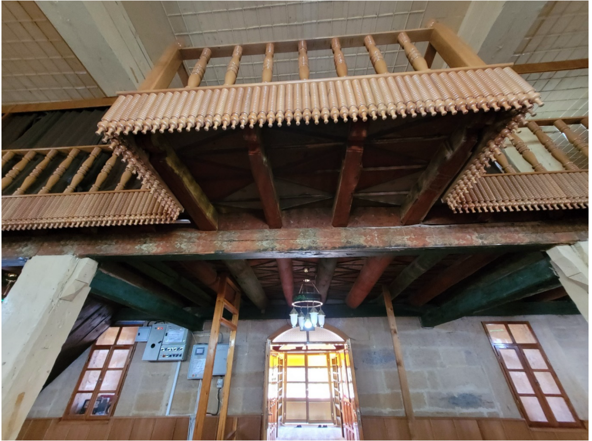
Fig. 30. Kadınlar mahfilini taşıyan ahşap kirişler, 2024
