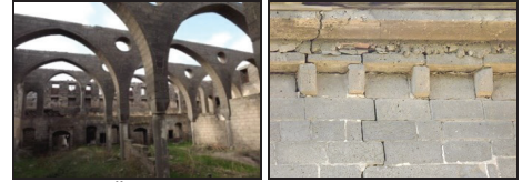
Şekil 2. Üst örtüsü tamamen çöken Surp Sargis Kilisesi ile Latin Kilisesi'ndeki çatlak ve ayrışma örnekleri
