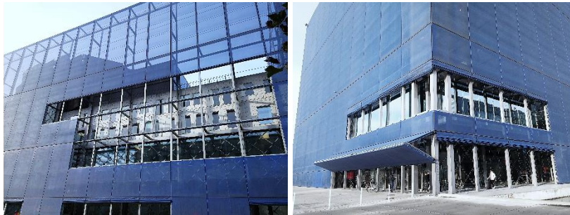
Şekil 7. Dış cephe fiberglas kaplamanın güneş kırıcı olarak kullanılması (M. Kavraz Arşivi, 2017).
