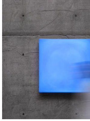
Şekil 4. Fil derisi betonarme duvar (URL10 (Roland Halbe)).
