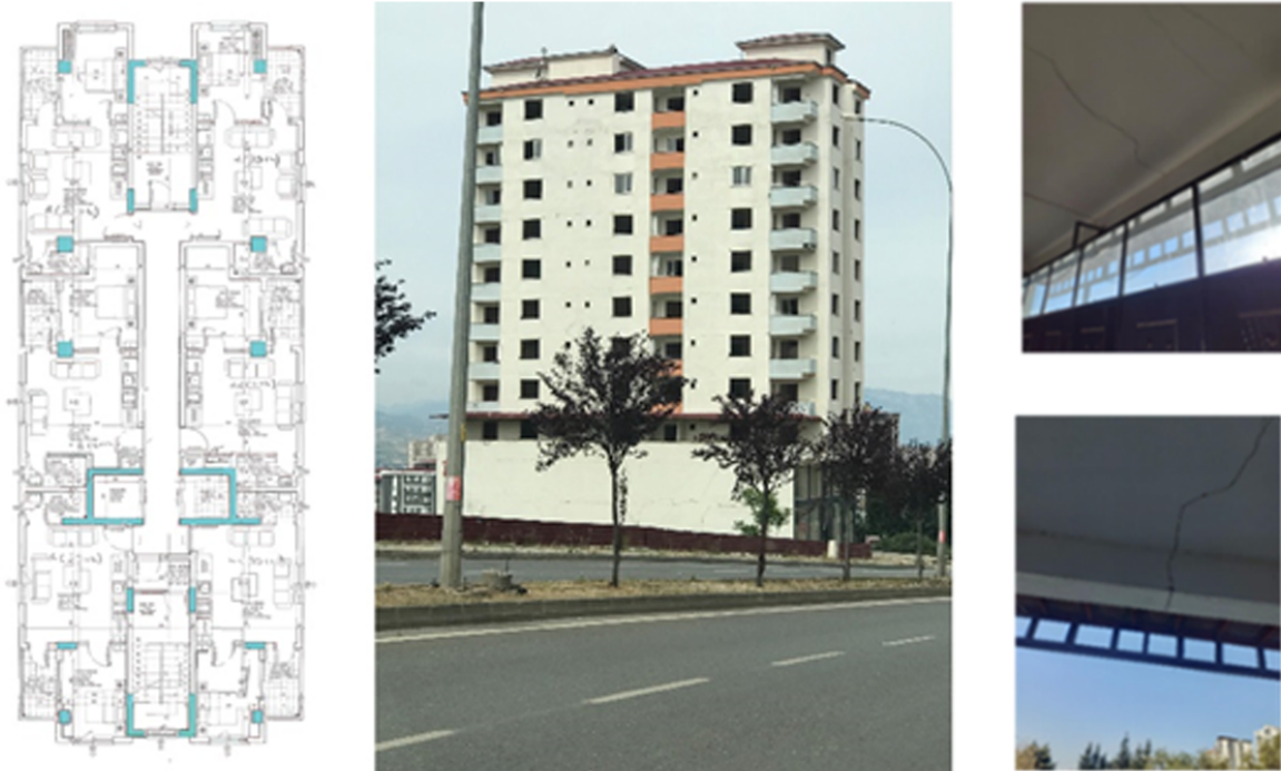
Şekil 2. Birden fazla cephede konsol çıkmalara sahip bir apartman binası, Kahramanmaraş 2024.
