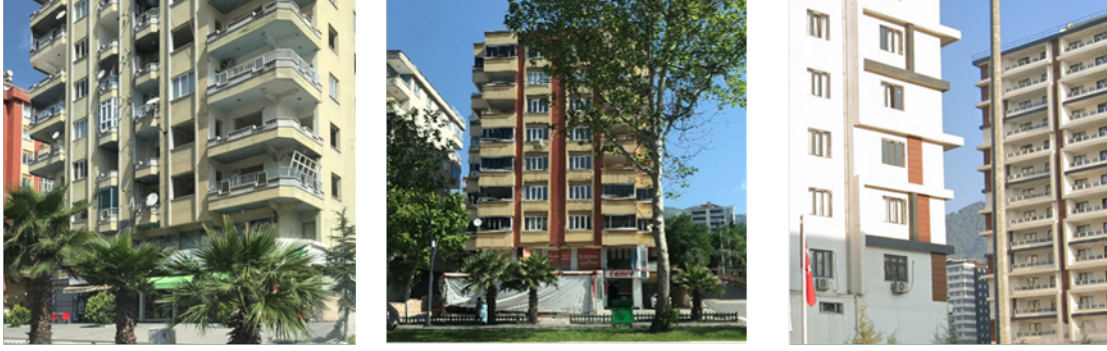
Şekil 1. Betonarme binalarda konsol çıkma örnekleri, Kahramanmaraş, 2024.
