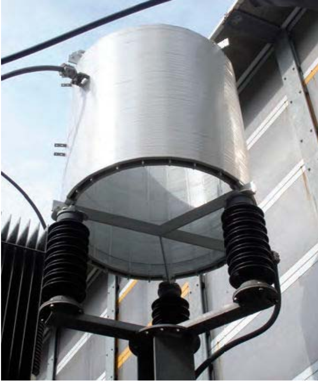
Şekil 2. Hava nüveli 4 kademeli reaktör [16] (Air core tapped reactor with 4 taps)
