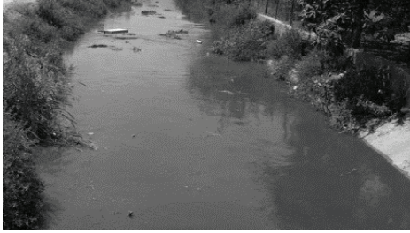
Şekil 7. Yıkama suyu kirliliği temizlik öncesi (yakın çekim)
