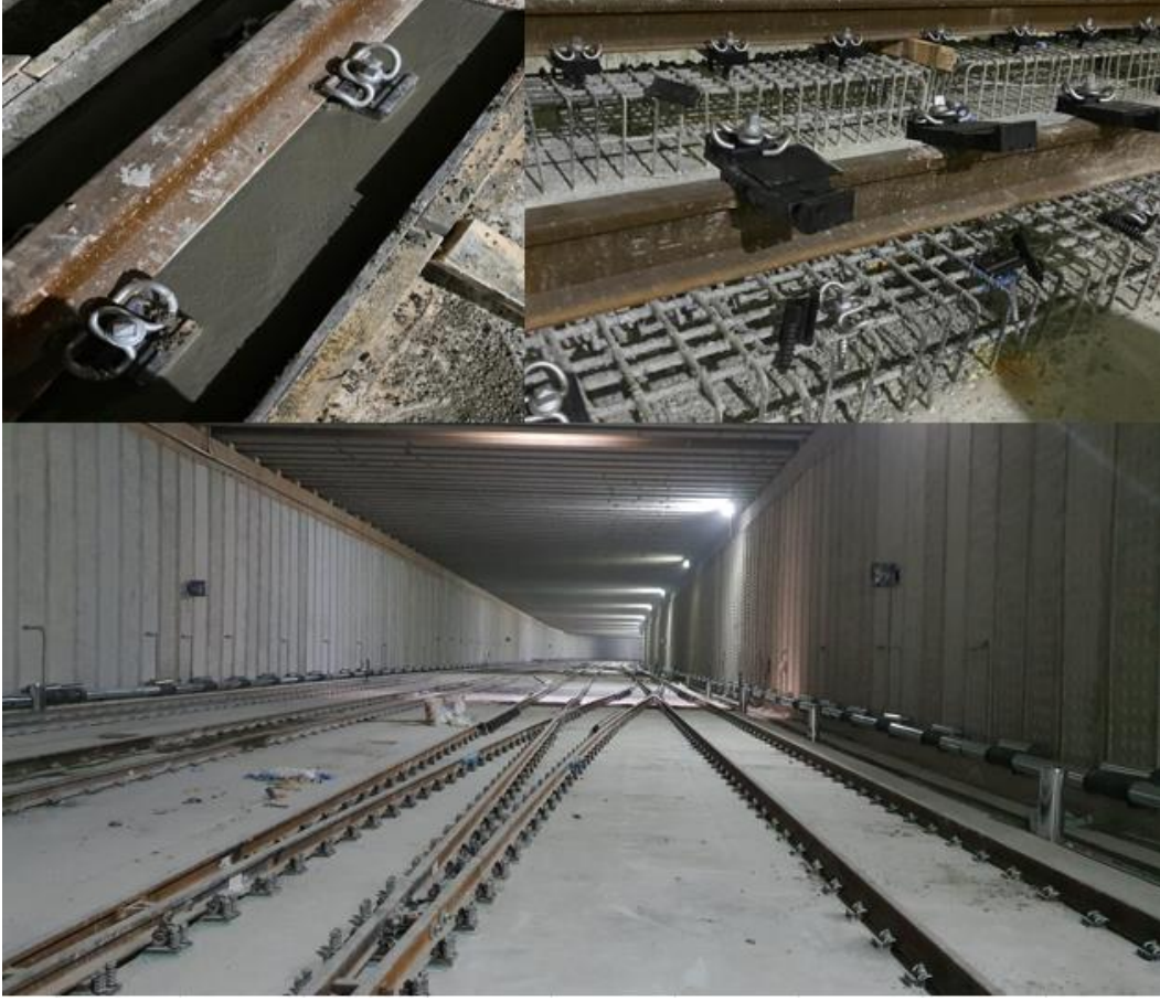
Şekil 4. Aç-kapa tünel yapısına ait üstyapı görüntüleri
