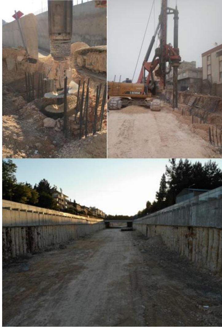
Şekil 2. Aç-kapa tünel yapısına ait kazık görüntüleri
