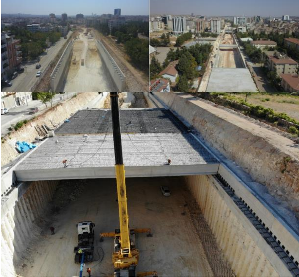
Şekil 3. Aç-kapa tünel yapısına ait kiriş montaj görüntüleri
