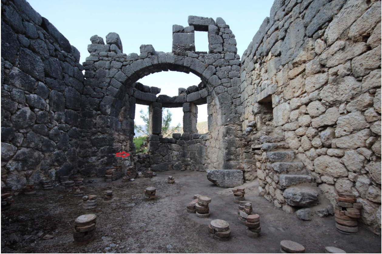
Şekil 13 VII. Hamam Praefurnium (Büyük Hamam'ın Erken Caldariumu) (Seviç, 2021)
