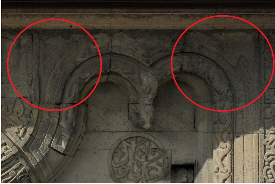
Fotoğraf 18: İnce Minareli Medrese- Taçkapının saçak kornişi kotundaki köşe profili ayrıntıları
