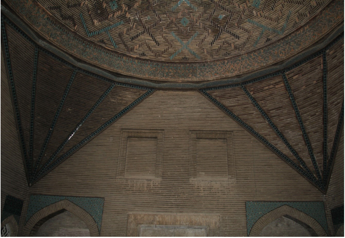
Fotoğraf 11: İnce Minareli Medrese - Kubbeli Orta Sofanın Doğu Duvarındaki Kapatılmış Pencere
