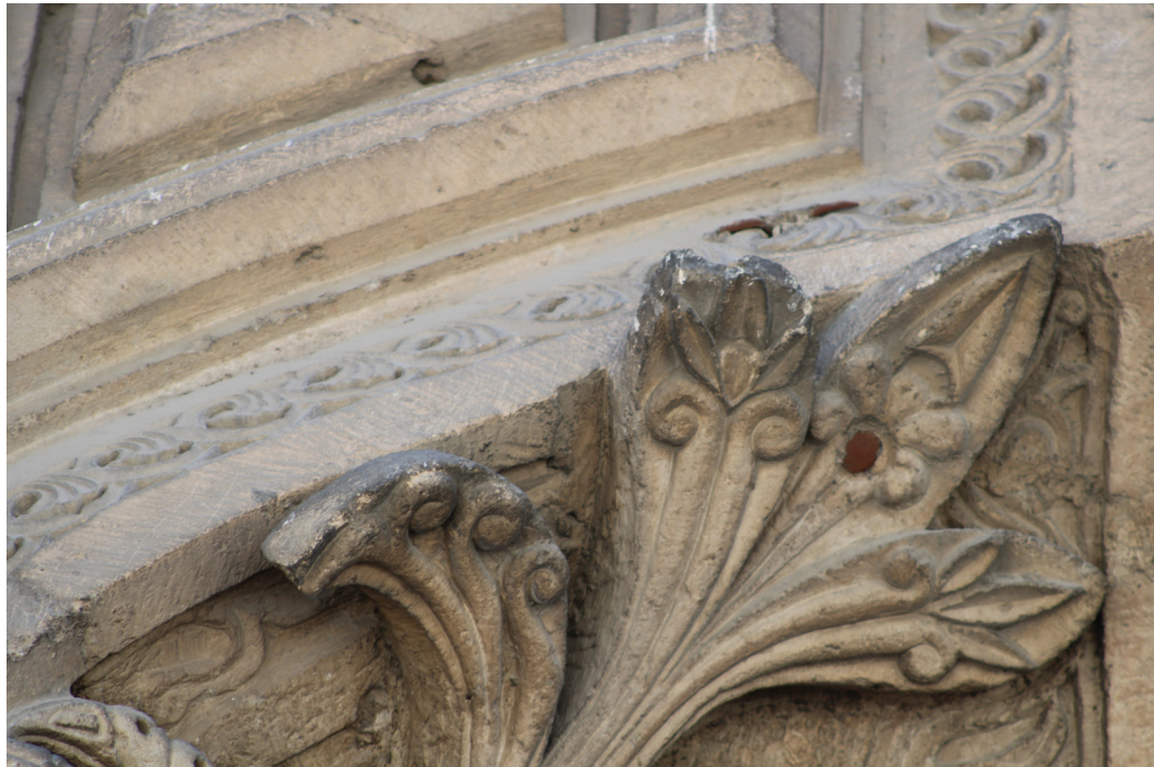
Fotoğraf 7: İnce Minareli Medrese Taçkapısı - “Hayat Ağacı”nın taç yaprağında taşa gömülü demir kabarı çivinin başlığı
