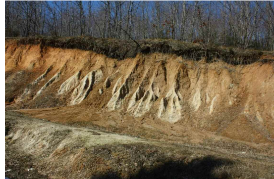
Fotoğraf 1. Bahçedağ güneyinde yapılan stabilize yol çalışmasıyla yamaç gradyanı bozulmuş, arazi örtüsünün ortadan kaldırıldığı sahalarda kırılgan ve alüvyal fanlar meydana gelmiştir (16.02.2017). Photo 1. Areas extinguished by land degradation.
