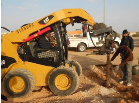
Şekil 2. Nivelman noktası çukurunun iş makinesi ile açılması
