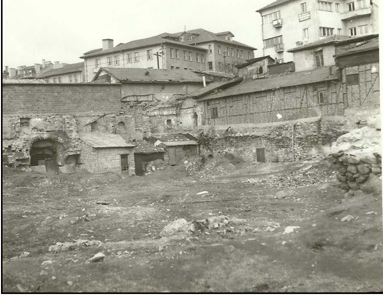
Fotoğraf 4: Sulu Han Kuzey Doğu Köşesi (Tamamıyla yıkılmış durumu) (1971) Kaynak: Vakıflar Genel Müdürlüğü Fotoğraf Arşivi
