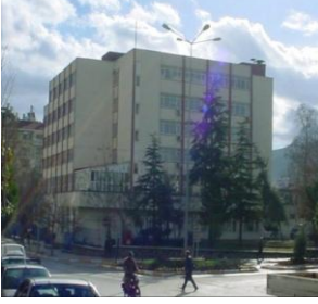
Resim 19. Orduevi Binası, 1974 (Ş. G. Beyhan Arşivi)
