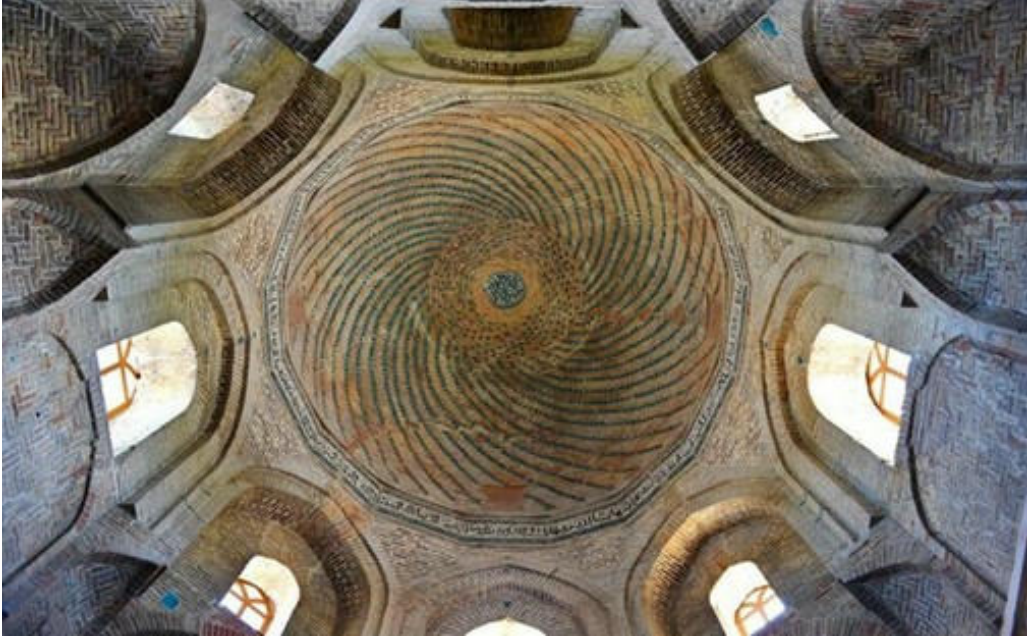
Görsel 4: Malatya Ulu Camii Mihrap Önü Kubbesi
