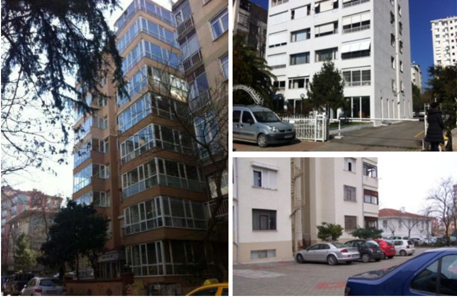
Şekil 16. Yüksek Katlı Apartman Döneminde Zayıflayan Konut-Bahçe-Sokak İlişkisi
