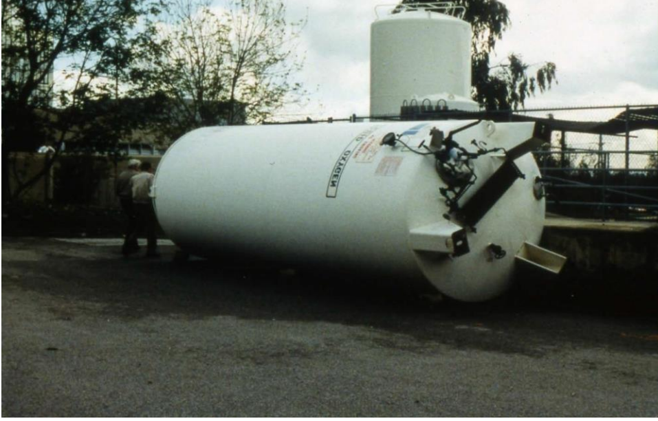
Şekil 6. Yetersiz bağlantı elemanları sonucu devrilmiş tank
