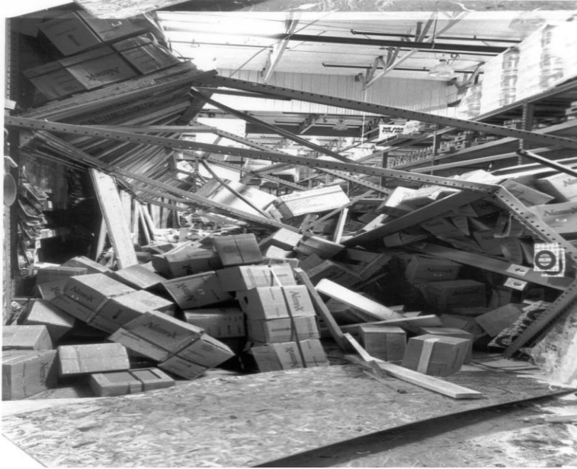
Şekil 7. 1994 yılındaki Northridge Depremi'nde devrilmiş raflar ve kaçış yollarının kapanması
