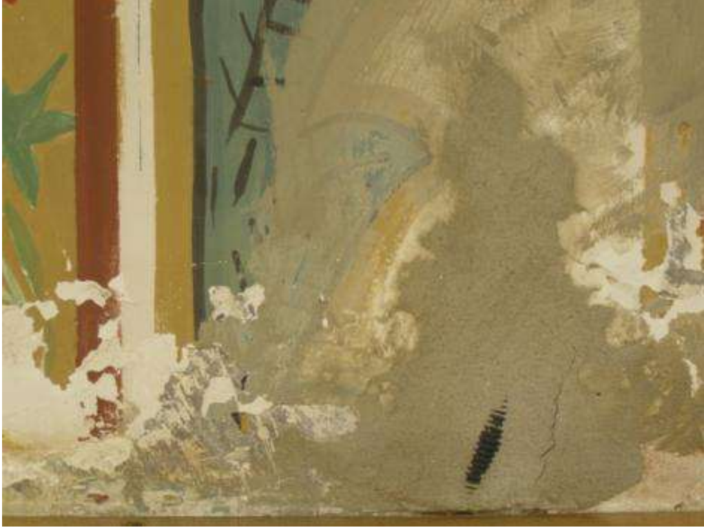
Resim 20. Tesisat Yenilemelerinden Bir Detay (E, Yetiş, 2015).
