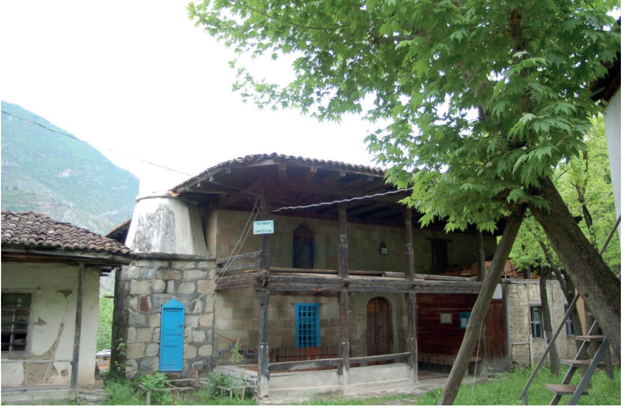
Resim 4. Zeytinlik Köyü Camii [10]
