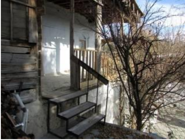
Şekil 9. Hayat-Dam-Bağlantısı(7 No'lu Ev)
