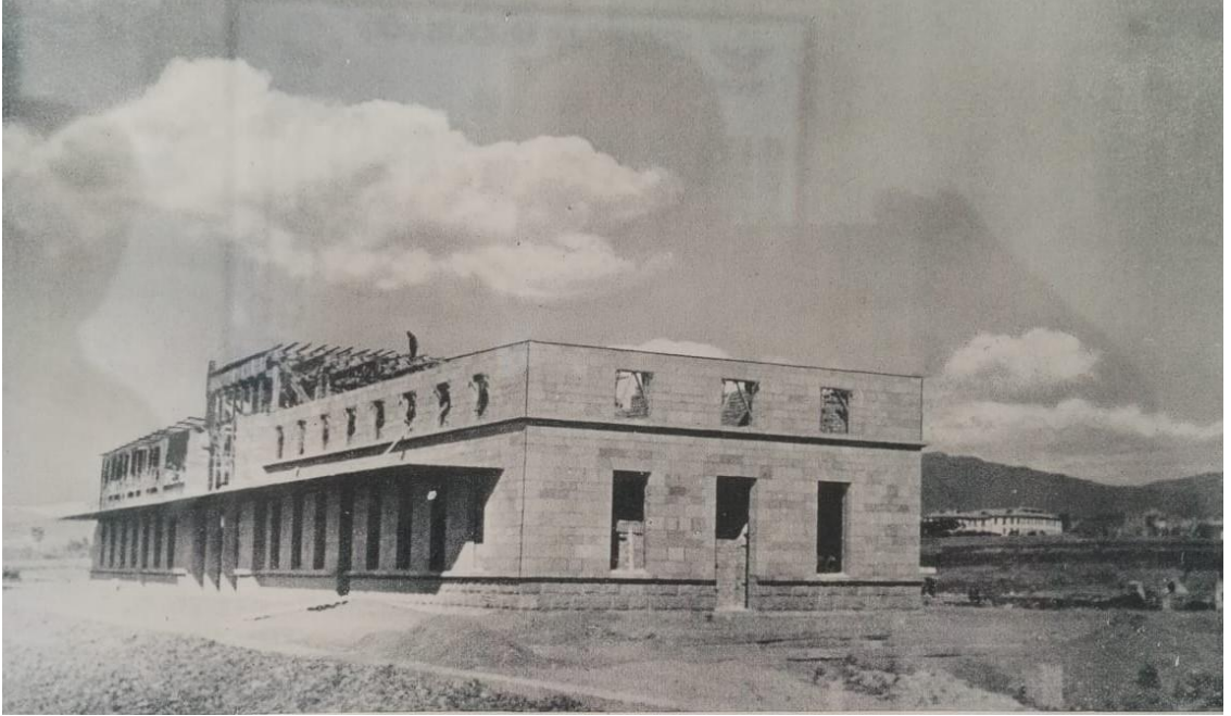
F.8: Erzurum Gar binası inşaatı
