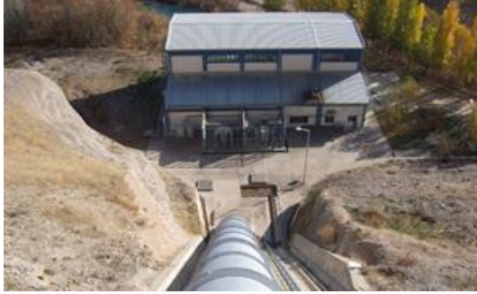
Şekil 1. Tesis genel görünüşü (General view of plant)
