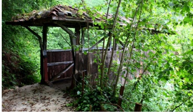
Resim 22. Güneybatı girişine mansab tarafından bakış.
