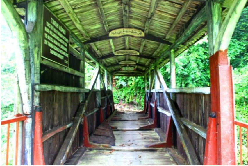
Resim 25. Köprü tabliyesi (kuzeydoğudan).
