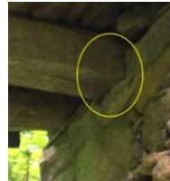
Resim 41-42. Kanallı geçmeler. Ana kiriş-yastık kirişi (41) (payanda-korkuluk kuşağı birleşimi (42).
