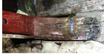
Resim 32. Tabliyede L payanda ayrıntısı.
