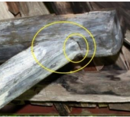
Resim 37-39. Kertmeli uç birleştirmeler. Payanda ve çatı kirişi (37), direk-payanda birleşimi (38), direk ve çatı kirişi ayrıntısı (39).
