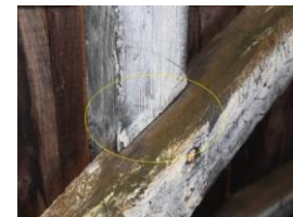
Resim 41-42. Kanallı geçmeler. Ana kiriş-yastık kirişi (41) (payanda-korkuluk kuşağı birleşimi (42).
