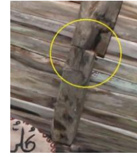
Resim 36. Düz boy birleştirme (ara aşıktan ayrıntı).
