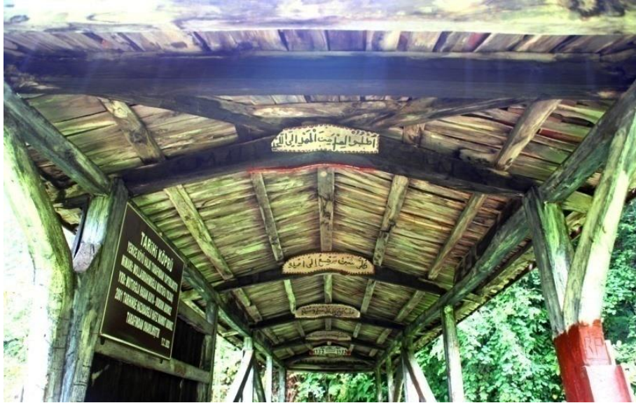
Resim 30. Çatı içten (kuzeydoğudan).
