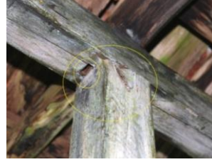
Resim 44. Zıvanalı geçme (direk çatı kirişi ayrıntısı).
