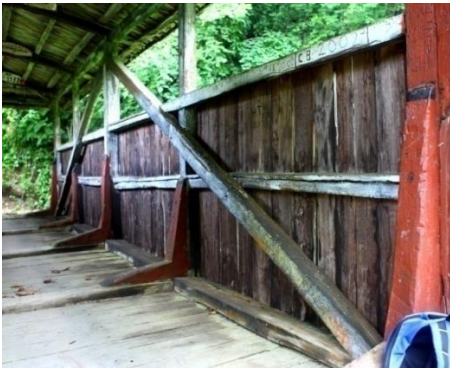
Resim 26. Tabliye korkuluğu içten (menba tarafı).
