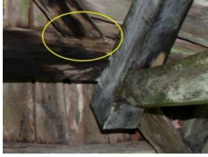
Resim 43. Kanallı geçme (ara aşıklar)
