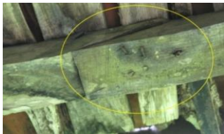
Resim 40. Pahlı (şevli) uç birleşme (aşıklardan ayrıntı).
