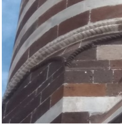
Şekil 3.25 Hüsrev Paşa Camisi on birinci kabartma
