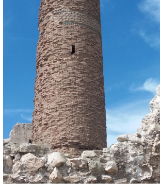
Şekil 3.4 Sinaniye Cami minaresindeki kabartmanın uzaktan görünüşü
