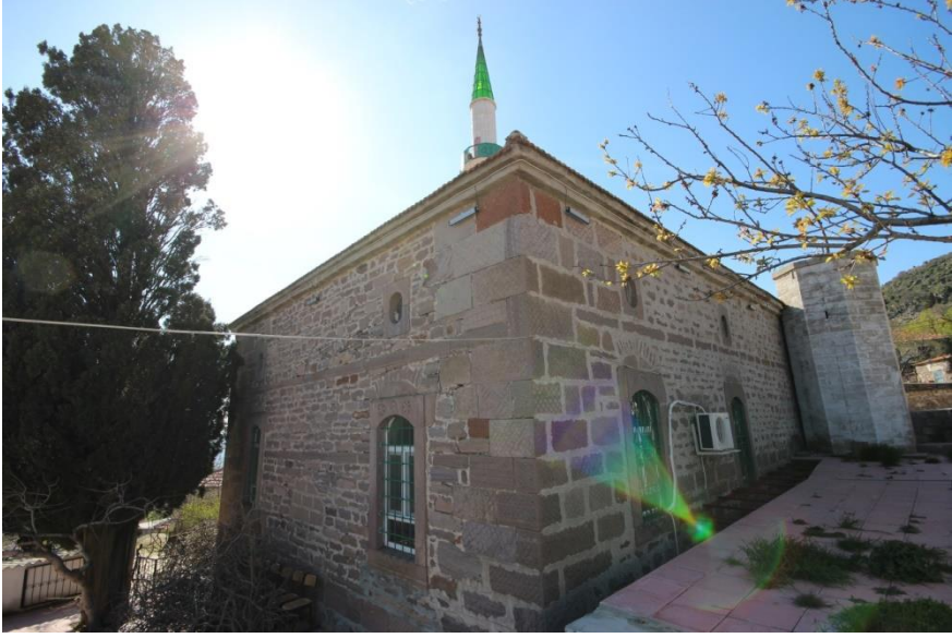
Resim-6: Yuntdağ Yenice Mahalle Camii Güneydoğu Cephesi.
