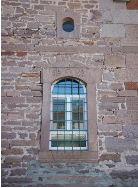
Resim-5: Yuntdağ Yenice Mahalle Camii Güney Cephe Pencere Açıklıkları.
